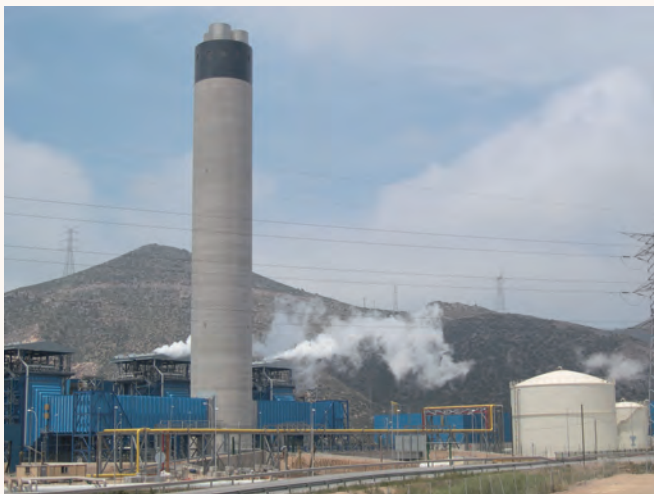
Nueva central térmica de ciclo combinado en Escombreras.
