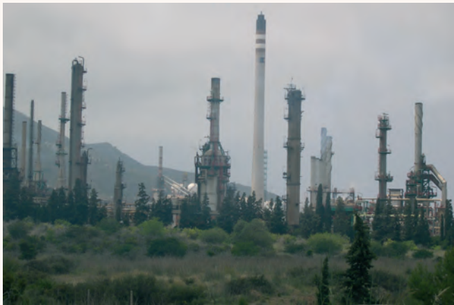
Instalaciones industriales del valle de Escombreras.
